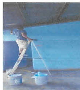
Foto 6: pintando aulas del modulo tres
