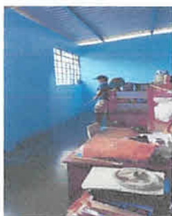
Foto 5: pintando los ambientes del modulo cinco
