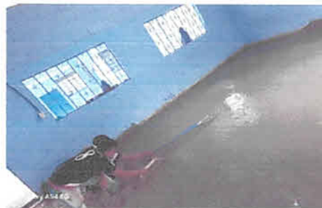
Foto 2: sustitución de piso de concreto modulo tres aulas
