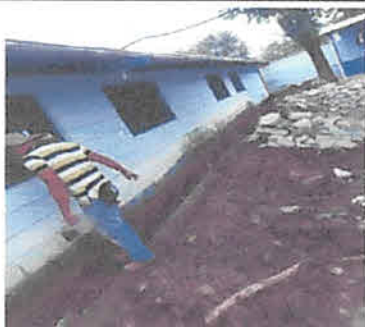
Foto 3: mejorando el cimiento de las aulas modulo tres por destrucción de raíces de arboles.
