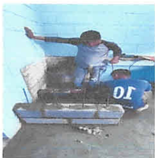
Foto1: sustitución de estufa comun por estufa rural completa.
