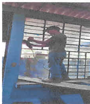
Foto 2: empezando la sustitución de la la ventana de la cocina
