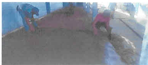
Foto1: sustitución de piso de concreto del corredor del modulo tres
