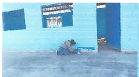
Foto 4: pintando el socalo del aulas del modulo tres.
