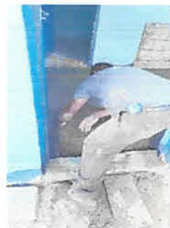
Foto 6: sustitución del piso de concreto de la cocina
