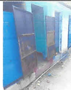
Foto 4: pintando las 5 puertas de los servicios sanitarios
